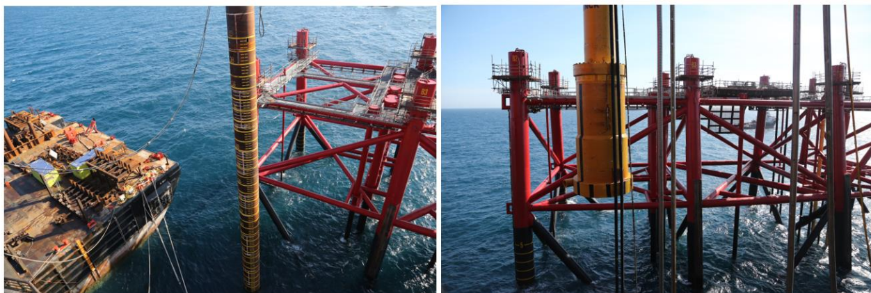
Figur 2-4 Pæl (venstre) og hammer til nedramning (højre)
